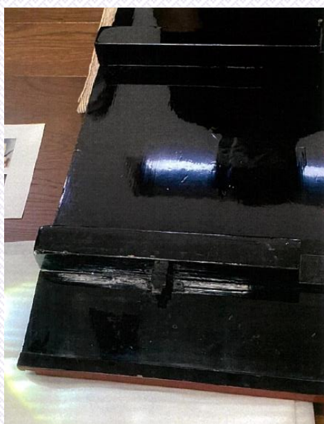
屋根板の修理
