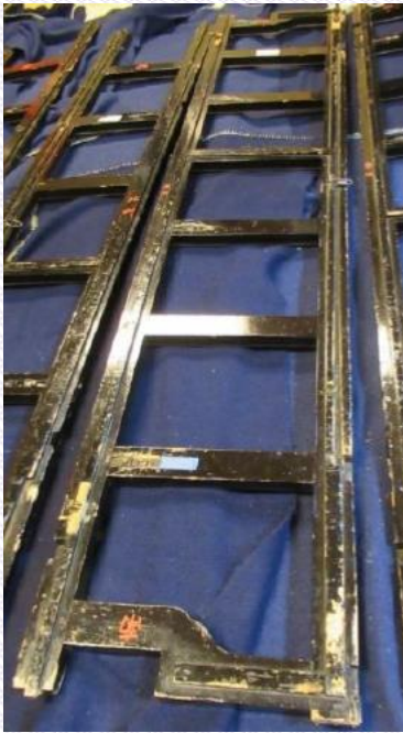
鉾部材の修理
