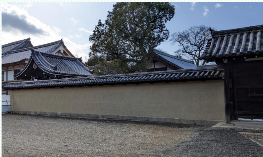
知恩院の土塀 下地の状況
