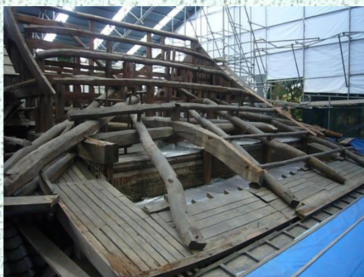
修理中の本堂
