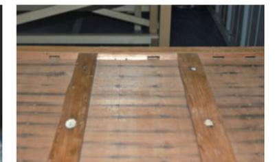
写真7 框部分に残る作業半ばの仕口穴
