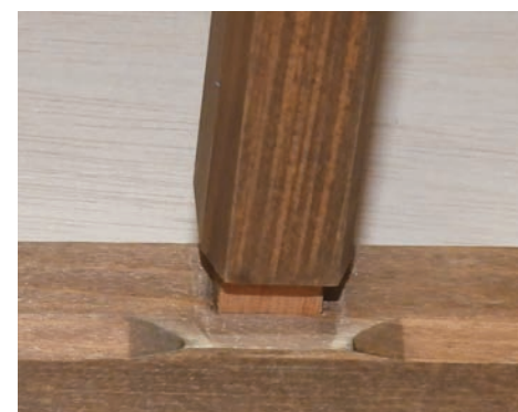
写真4 柄差し 凹ませた柄を手早く仕口挿入する。
