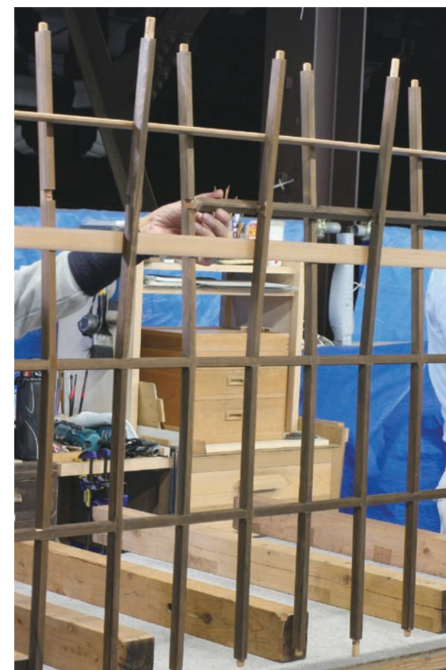
写真5 地獄組 棧を撓（しな）わせる作業は慎重さと大胆さが必要。
