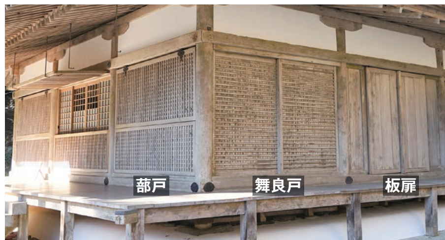
図1 建具の種類と名称（筆者撮影：以下記載のない写真は筆者撮影）
