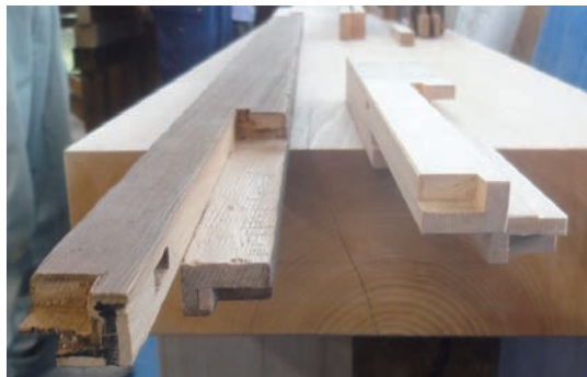
図3 同左の継手（複雑な加工がされている）
