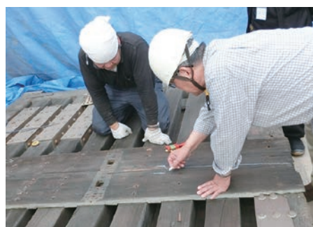
図5 古い材料を最大限生かすために修理の箇所と方法を指導する様子
