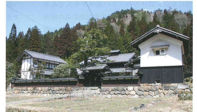
写真9 開原家住宅の屋敷構え（左京区花背原地町）
