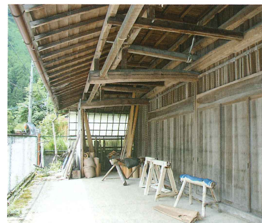
写真3 福新商店丸太乾燥小屋の木組み
