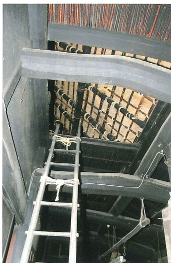
写真13 瀧井家住宅の土間上部の梁組
