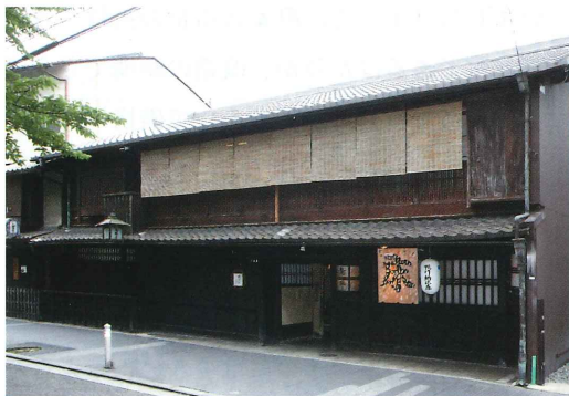
写真3 鳥彌三（登録有形文化財、天明8年〈1788〉大火後の再建、下京区西石垣通四条下る芥藤町）
