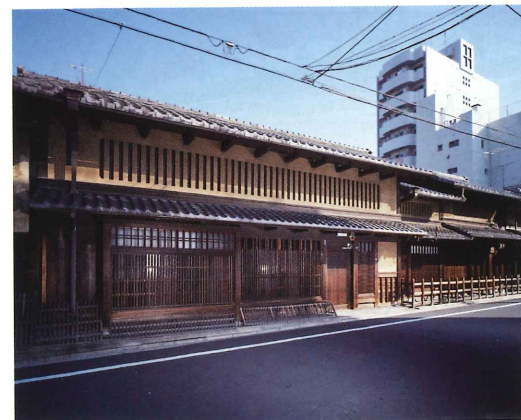
写真6 杉本家住宅「奈良屋」（京都市指定有形文化財、明治3年〈1870〉上棟、下京区綾小路通新町西入矢田町）
