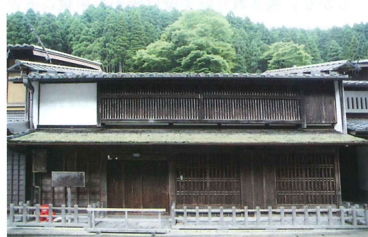
写真4 滝澤家住宅（重要文化財、宝暦10年〈1760〉築、左京区鞍馬本町）
