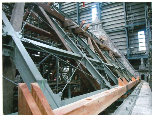
今回新たに挿入した補強鉄骨材
