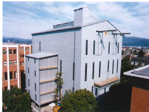
工事期間中の素屋根（まもなく取り払われる）
