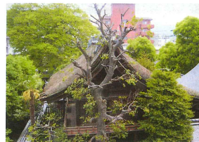
熊野神社の本殿屋根葺替工事
