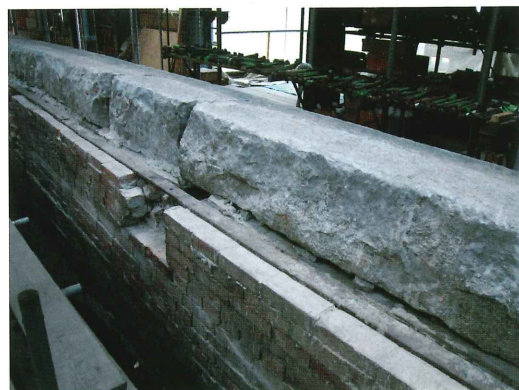
煉瓦壁頂部付近に挿入されていた鉄のプレート
