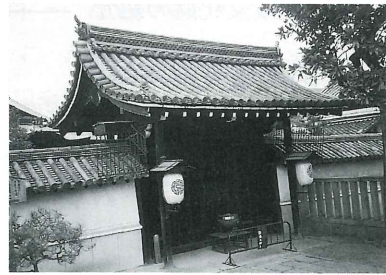
観智院南門 京都市南区八条北大宮西入る九条町 教王護国寺（東寺）の中でも格式を誇る塔頭寺院で、 当院の南門は17世紀中期の建立と伝わる建物で、老朽 化による瓦の損傷等が著しい為、この度修復された。
