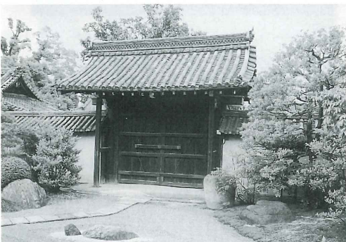
一観智院南門一 教王護国寺(東寺)の塔頭寺院で、南門は17世紀頃の建立と伝えられるもので、老朽化による屋根瓦の損傷が著しいため、修復工事が行なわれる。
