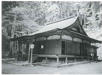
高山寺金堂 京都市右京区梅ヶ畑 桐尾町 寛永11年（1634） に当寺に移築され た建物で、このた び床下等の損傷が 著しい為、修復さ れた。
