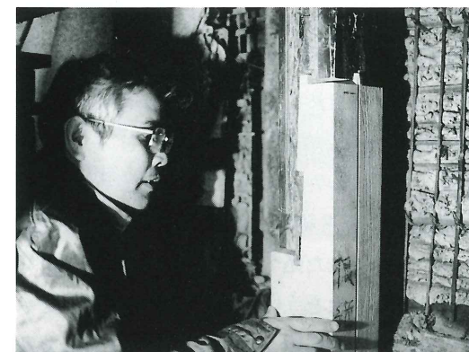
町家の再生工事で、腐蝕した柱下端部を伝統的な大工仕事で根継ぎする。町家を扱うさいにも、文化財建造物の修理技術が大いに参考になる。
