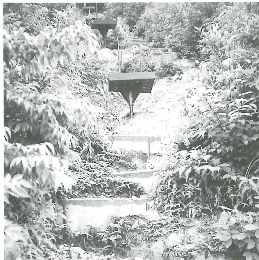
大文字五山火床整備。写真は、松ヶ崎妙法火床及び山道改修工事。
