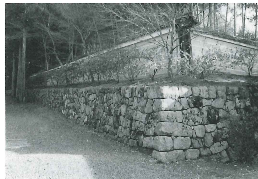
—曼殊院境内周囲土堀修理工事— 数多くの文化財を所蔵している当寺の景観を形成している境内周囲土堀の破損が著しいため、今回全面的な修理工事が行われました。
