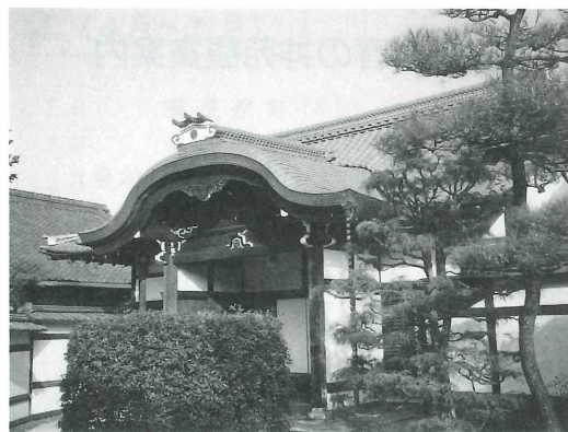
—三時知恩寺大玄関— 当時は、室町時代中期の創建と伝えられる浄土宗尼門跡寺院で、大玄関は享和2年(1802)光格天皇の援助により再建されたものです。今回、屋根の破損が著しいため葺替工事が行われました。
