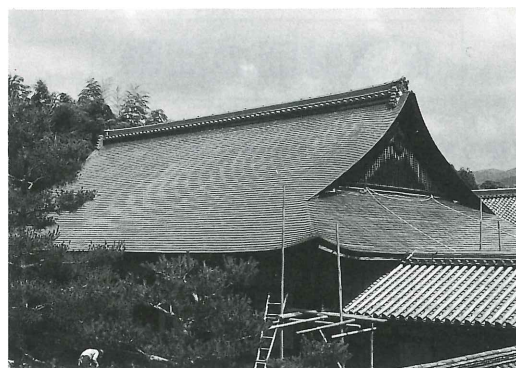
—妙心寺 霊雲院本堂— 元禄6年(1693)の建立で、屋根の傷みが著しいため今回、全面的に屋根の葺替工事がおこなわれた。
