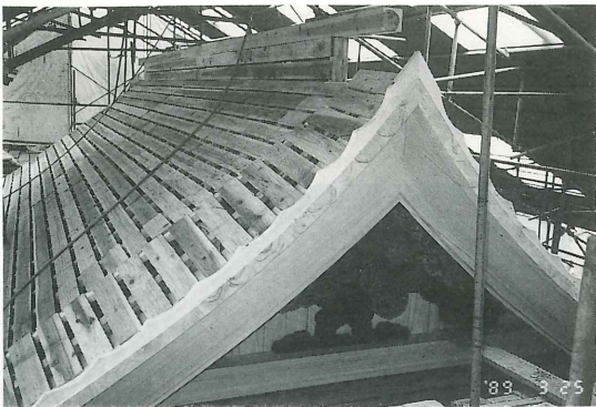
建造物の屋根工事
