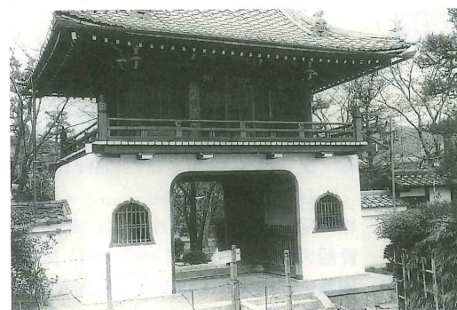
一元慶寺（京都市山科区）鐘楼門一 寛政9年（1797）の建立と伝えられる竜宮造りの表門で、今回解体修理工事がおこなわれた。
