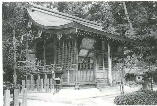
一八幡社（京都市左京区）本殿一 三間社流造で、江戸時代前期の建立といわれる。今回、屋根葺替工事がおこなわれた。
