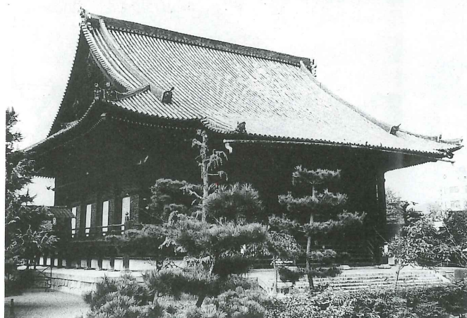
安永3年(1774)建立の本堂 土壁なしの総檜造の大木造建造物である。
