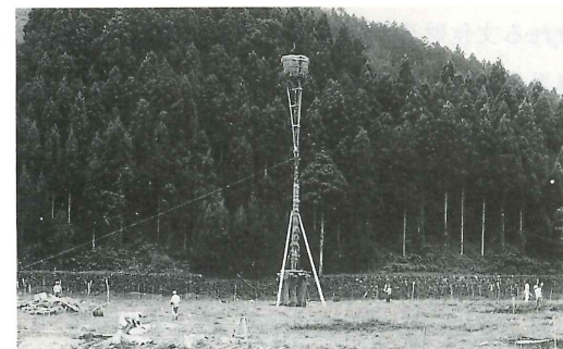
トロ木は、高さ約20メートルの檜の丸太で先端の大笠は、深さ約1.5メートルの茅でつくられたもので、その中に杉の枯葉をつめ込み、藤づるで巻きつけられている。トロ木建ては、昭和30年頃までは人力で建てられていた。
