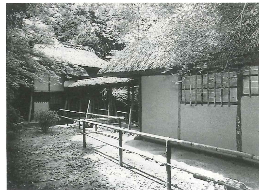
高台寺時雨亭と傘亭 重要文化財
