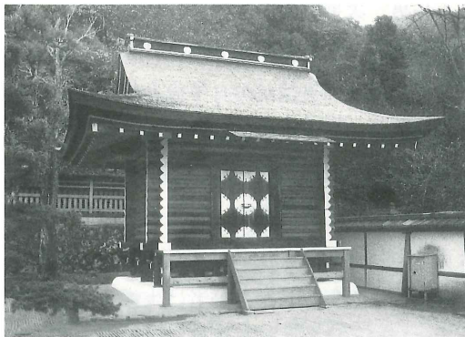
—松尾大社神庫— 文久3年(1863)に建立された校倉造りの宝物庫で、今回屋根葺替など修理工事がおこなわれた。
