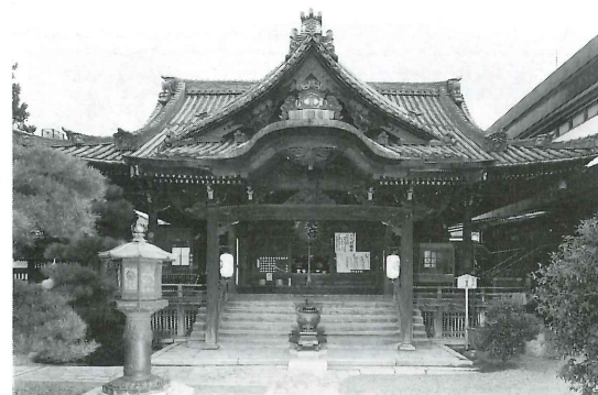
一本堂—西国巡礼の札所本堂として貴重な建物である。 (文化12年建立・京都市指定)
