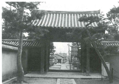
—大徳寺南門— 江戸時代初期の建築様式を伝え、今回解体修理工事がおこなわれた。
