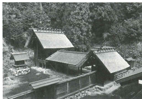
—日向大神宮内宮本殿及び拝所— 伊勢神宮と同じく内宮、外宮からなり神明造りの建築様式を伝えるもので、今回屋根葺替工事がおこなわれた。
