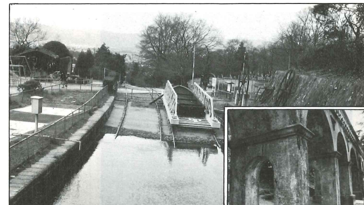
インクラインと水路閣（京都市指定・京都市左京区南禅寺福地町他） 近代京都のまちづくりの基礎となった疏水事業。その一環として施工されたもので、水路閣は、延べ約93メートル、幅 4.5メートルのレンガ造、アーチ構造の特異な景観を呈している。（写真右下）又、インクラインは、蹴上の舟だまりと南禅寺の舟だまりまでの急勾配に軌道を敷き、艇架台により舟を運ぶ施設である。ともに、京都の近代化をみるうえで貴重な明治の史跡である。
