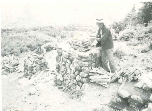
傷みが激しいため、改修工事がおこなわれた大文字五山送り火の左大文字の火床（写真：準備風景）
