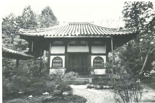
—林丘寺開山堂— 屋根瓦の破損が著しかったが、当財団の助成により修復された。
