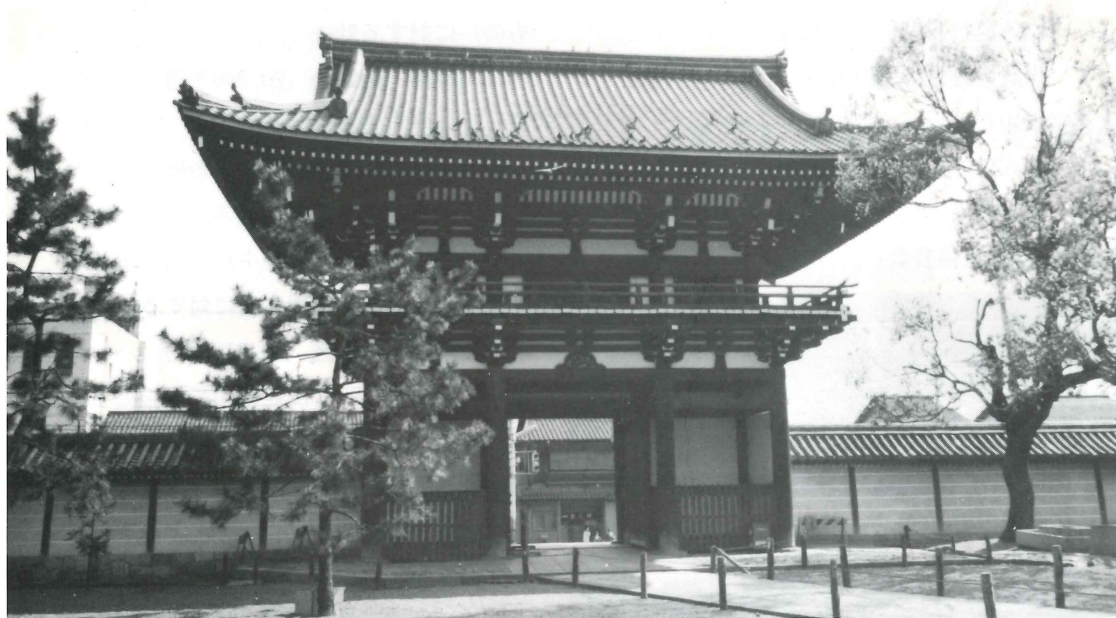
—広隆寺南大門— 元禄15年に再建された三間一戸、入母屋造の仁王門で当寺のシンボルとして有名。今回、およそ50年ぶりに修理が行なわれ、当財団補助対象となる。
