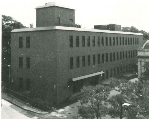
文化財保存修理所 全景
