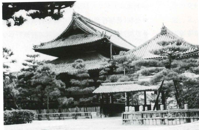
—浄福寺本堂—享保18年建立で仏殿棟（寄棟）と外陣棟（重層造）を内陣でつなぐ形式をもつ。今回破損著しいため修理が行なわれ、当財団補助対象となった。
