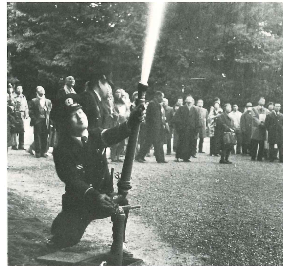
防災施設の見学 泉涌寺仏殿前の放水銃による放水
