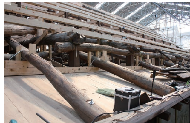
等持院方丈修理状況
