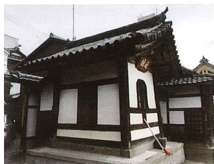
六道珍皇寺(京都市東山区)鐘樓修理事業
