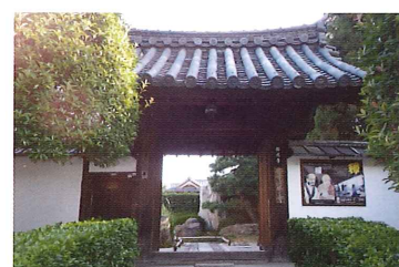
願成寺(京都市東山区)山門修理工事 東福寺塔頭寺院で元治元年(1864)頃の建立とされる山門。屋根、木部の損傷が著しいことから修理工事が行われる。
