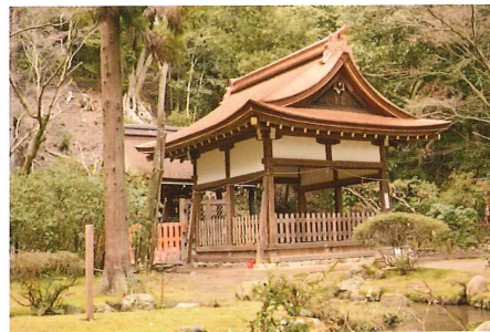
賀茂別雷神社（上賀茂神社・京都市北区） 摂社山口社本殿屋根葺替工事
