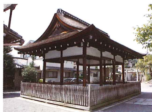
今宮神社（京都市右京区） 拝殿修理工事
