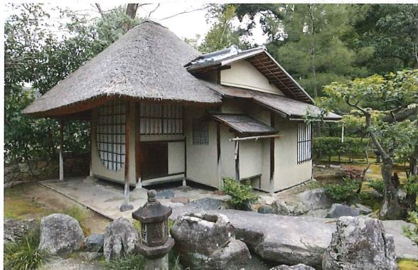
根をもち、正方形に近い壁面に大きな円窓があけられ、丸と三角そして四角が表現されたユニークな形をしています。室内は一畳台目で、向板が嵌められ二畳の大きさとなっています。炉は向切逆勝手、床の間は向板の壁に釘を打ち、掛け物が掛けられるようにした壁床の形式です。客の出入口として躰口、亭主の出入口として開き戸形式の茶道口が設けられています。天井は竹簾張りで、炉の上には杉丸太の横木に蛭釘が取り付けられ、釜を釣ることができますように工夫されています。客座側の大円窓、いわゆる吉野窓の内側には障子が建てられていますが、あけることを考えたものではなく、障子に映る円形の光に吉野大夫を偲んだ形式だとも考えられます。
