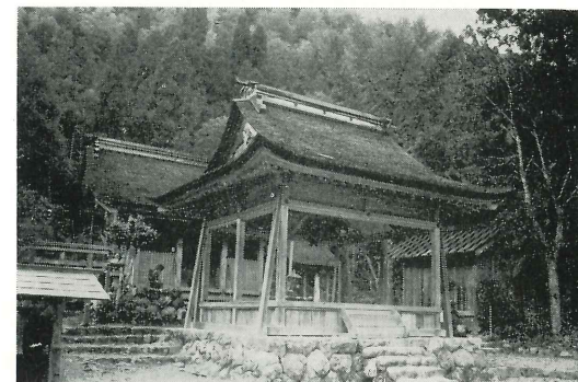
昭和48・49年度当財団補助金により修復された久多志古淵神社
