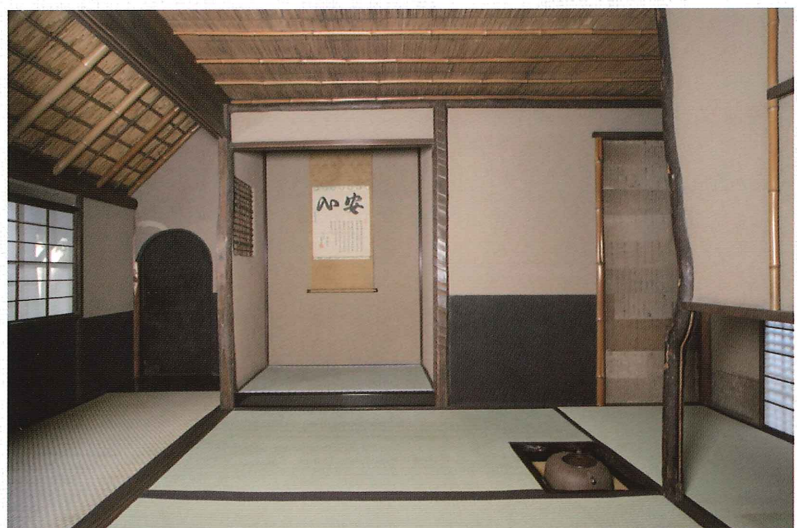
藪内家燕庵内部 左が相伴席、右が点前座、袖壁の下が吹き抜けている 写真／公益財団法人 藪内燕庵所蔵
