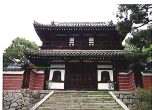
建仁寺 開山堂楼門修理工事
