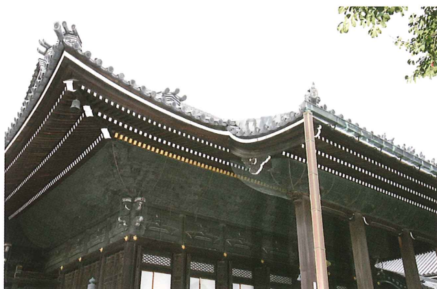
図4 本堂軒裏 三段の垂木で構成されている軒
