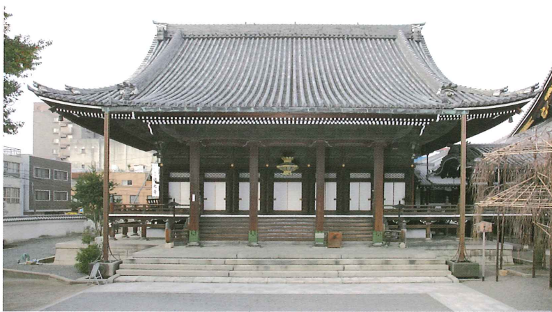
図3 本堂正面全景
