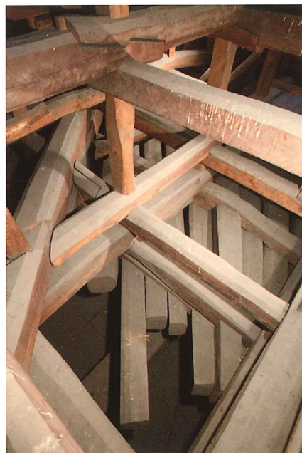
図5 本堂小屋組 扇状に敷き並べた枯木材を基盤に小屋組が構成される
