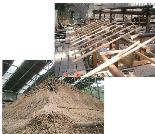
組上げられる新旧の木材（写真：上）と葺替えの様子（写真：下）
